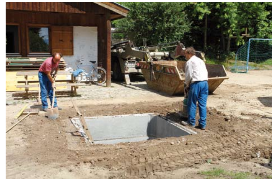
Für starke Regenfälle wurde ein Wasserauffangbecken auf dem Bolzplatz angefertigt
