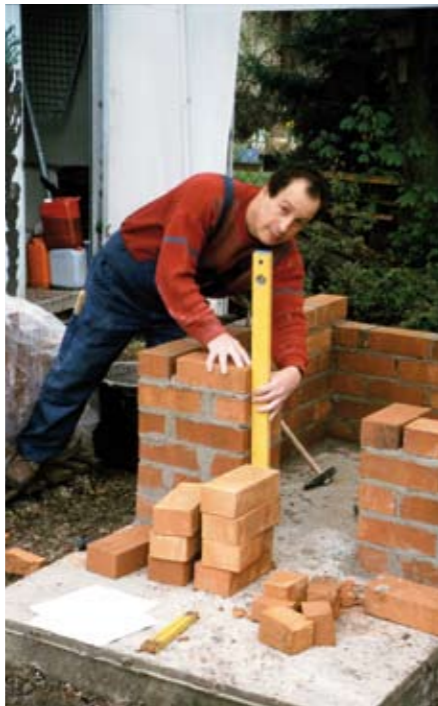
Der Backofen wird gemauert ...
